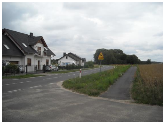
Wyremontowana droga powiatowa ze ścieżką
