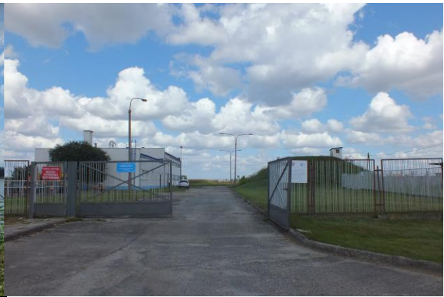
Stacja Uzdatniania Wody
