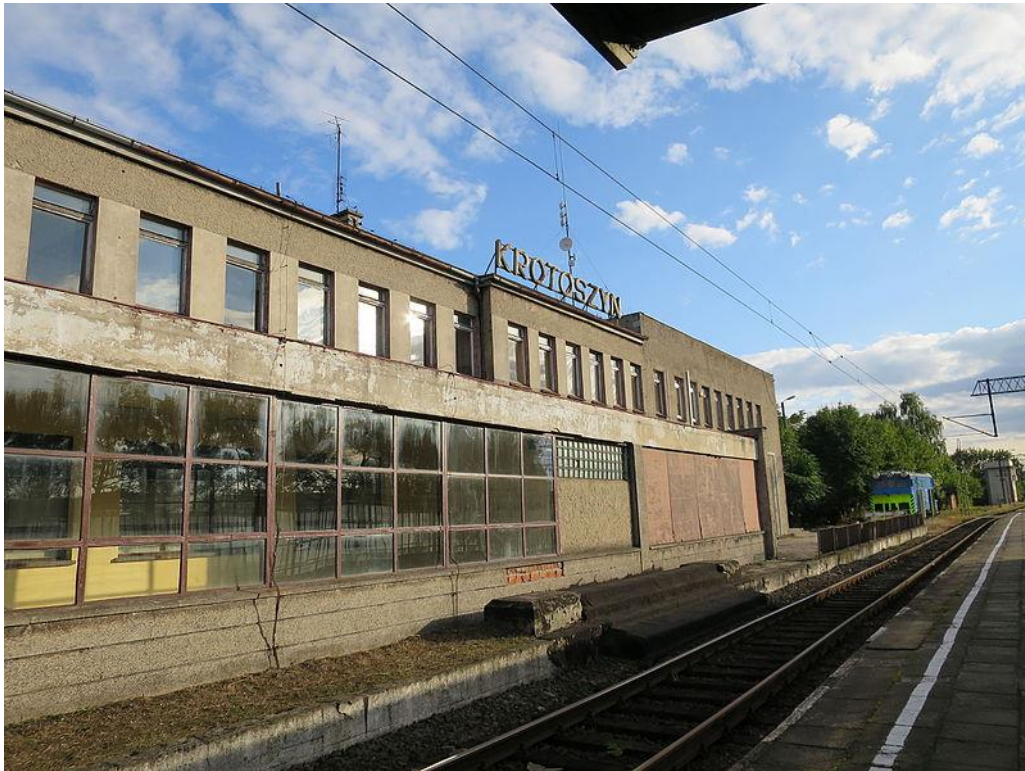
Fotografia 5. Stacja kolejowa w Krotoszynie, fot.1
