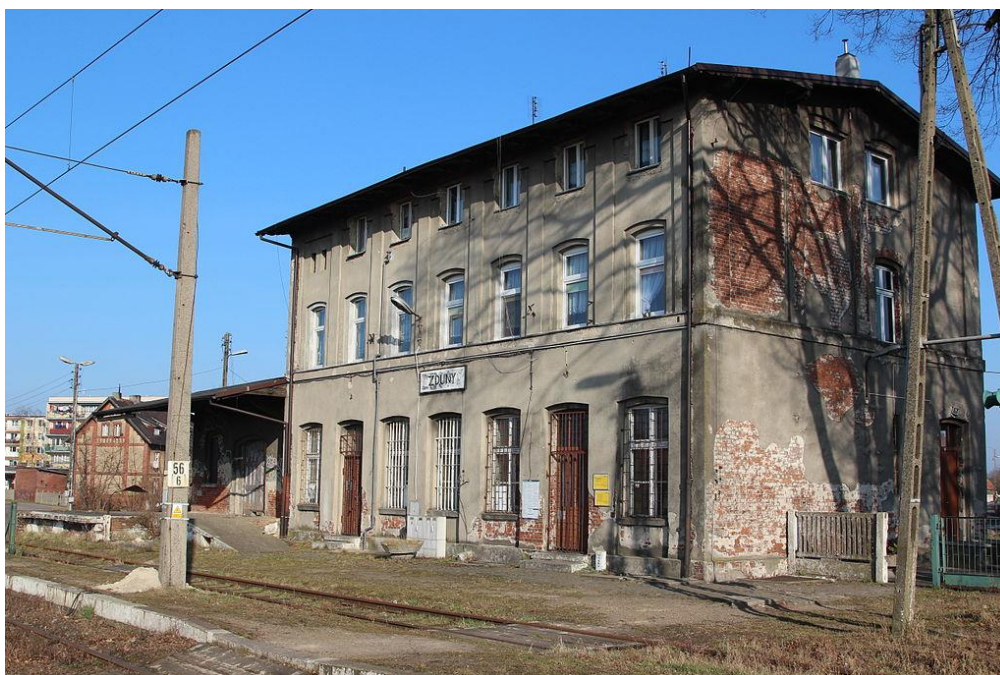
Fotografia 7 Stacja kolejowa w Zdunach
