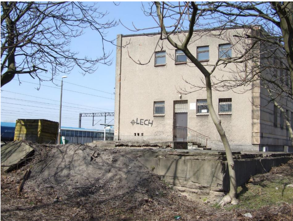
Fotografia 6. Stacja kolejowa w Krotoszynie, fot.2
